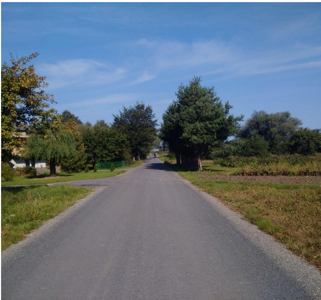
Przebudowa odcinka drogi w miejscowości Zwola
