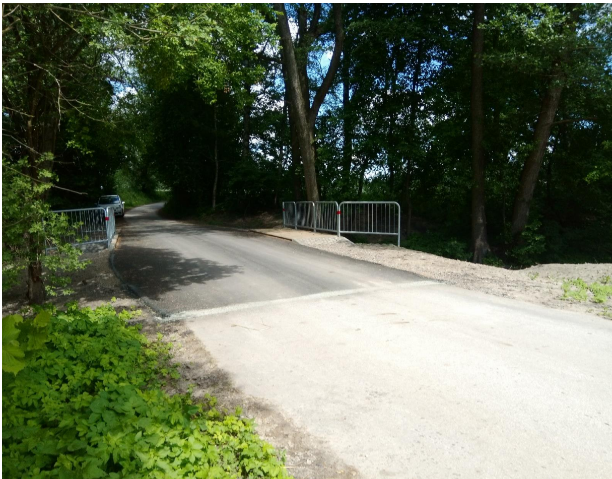
Modernizacja mostu na drodze w miejscowości Markowola
