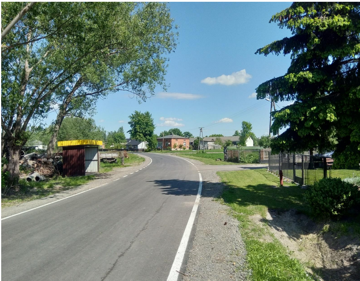
Przebudowa odcinka drogi w miejscowości Wólka Bachańska
