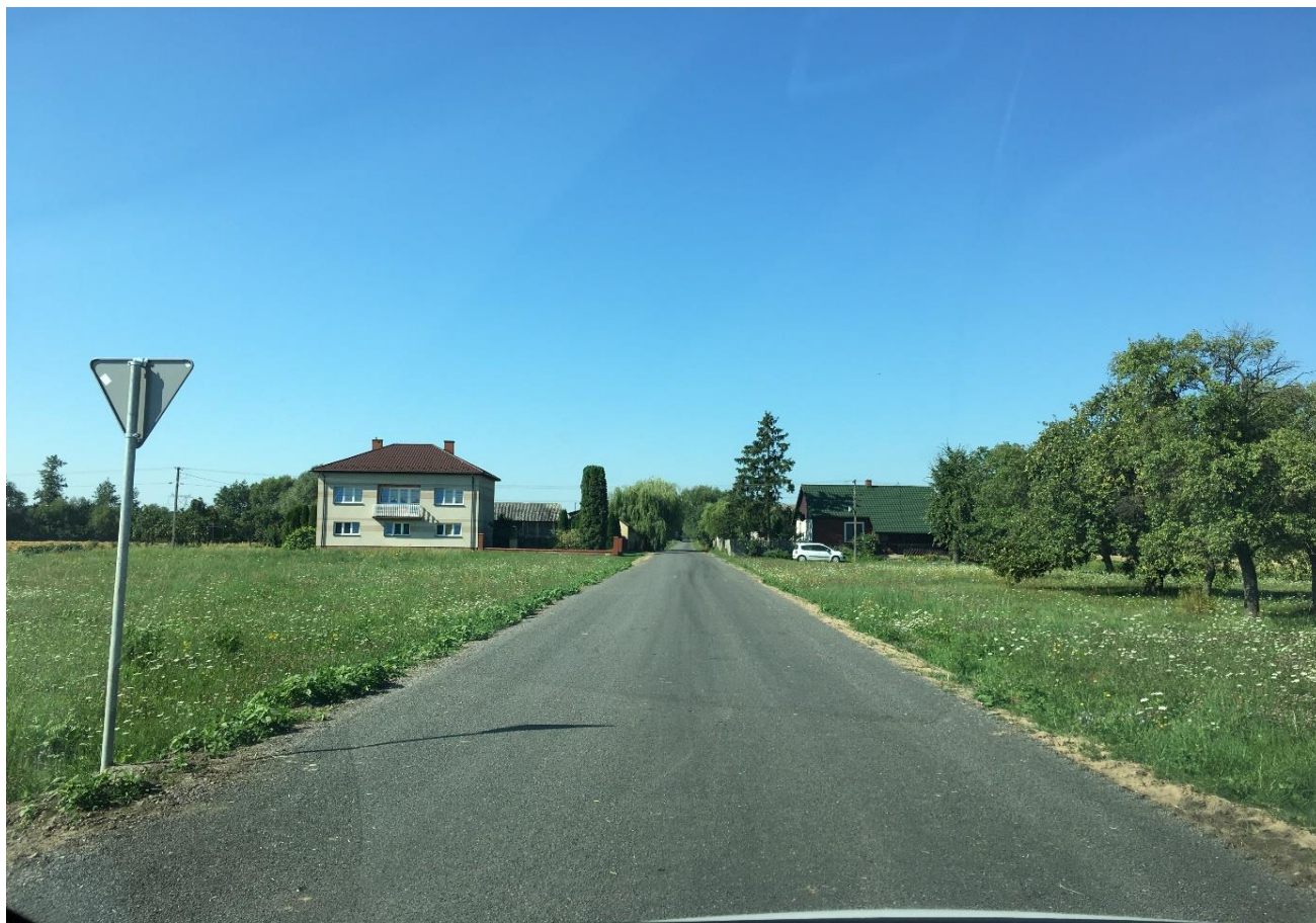
Przebudowa odcinka drogi w m. Sławczyn.
