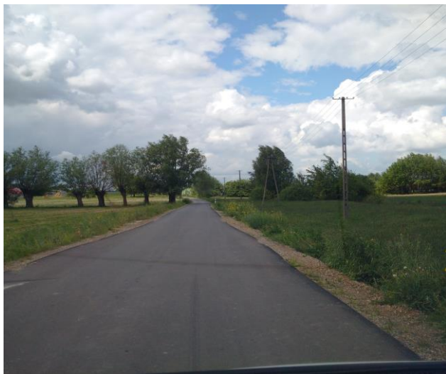
Przebudowa drogi Zwola-Sarnów „Prusiny”
