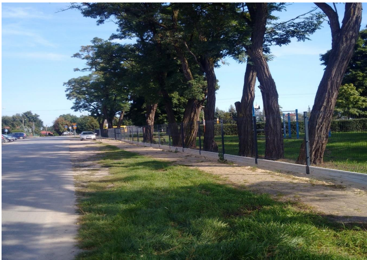
Budowa ogrodzenia przy Szkole Podstawowej w Wysokim Kole
