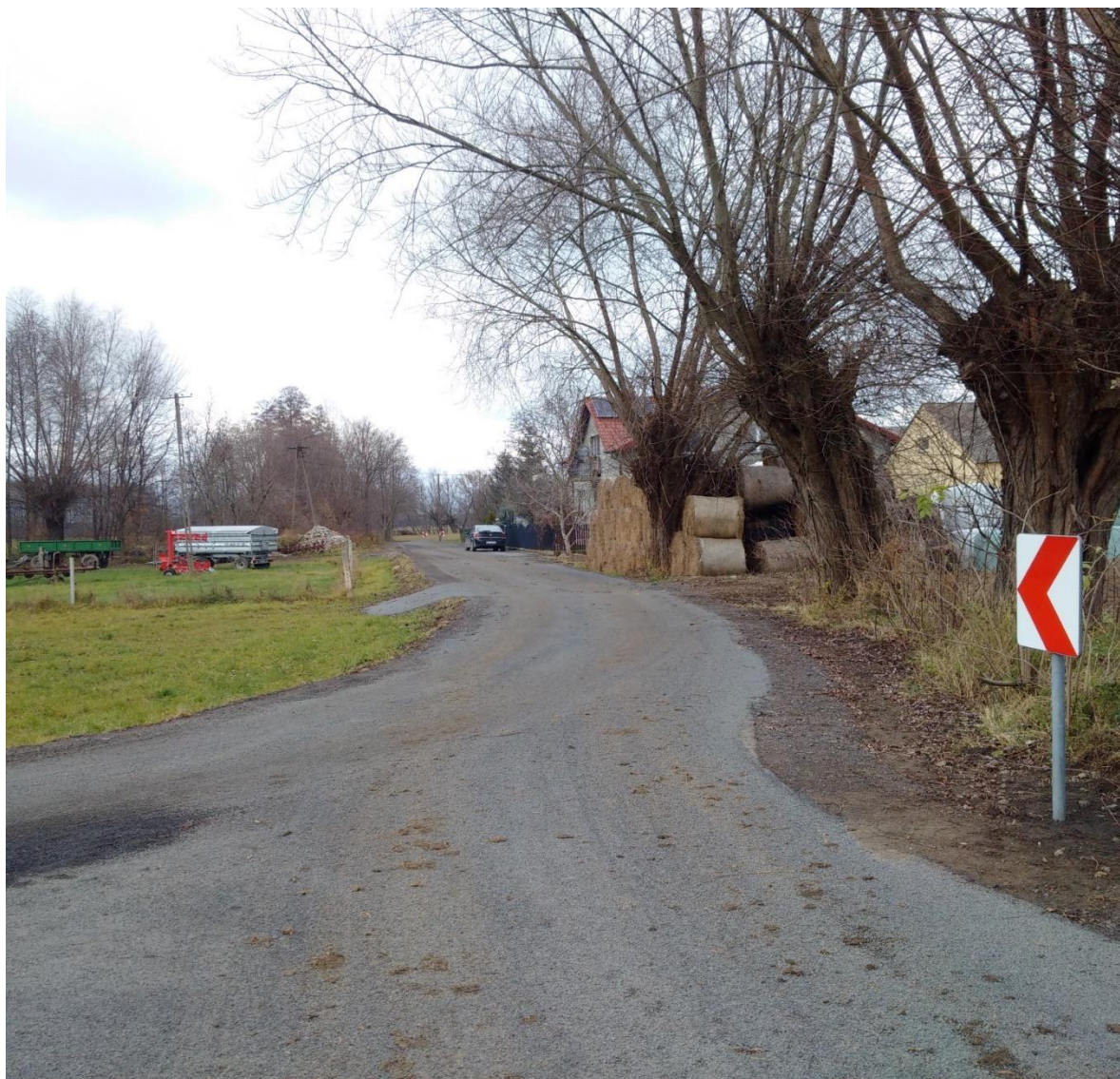
Przebudowa odcinka drogi w miejscowości Oleksów od km 0+000 do km 0+425, w ramach zadania budżetowego: Przebudowa odcinka drogi w miejscowości Oleksów „Gruszka”
